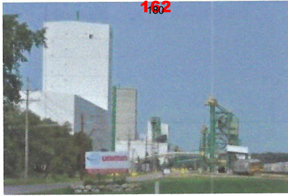
Fig. 13. Unimin Kasota Plant.
